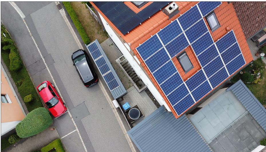
**Abbildung 6.14** Das sanierte Dach mit PV-Anlage
