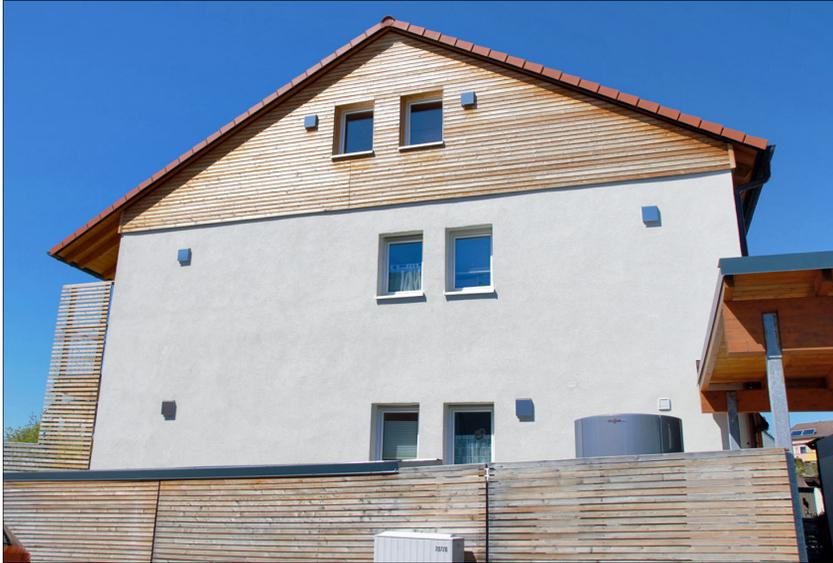
**Abbildung 6.13** Die quadratischen Luftauslässe und -zulüsse ermöglichen eine Wohnraum-
