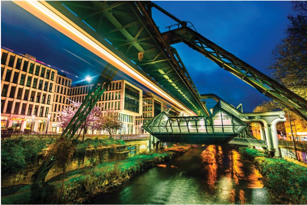
Abbildung 1.6: Mischlicht an einer Schwebbahnstation
