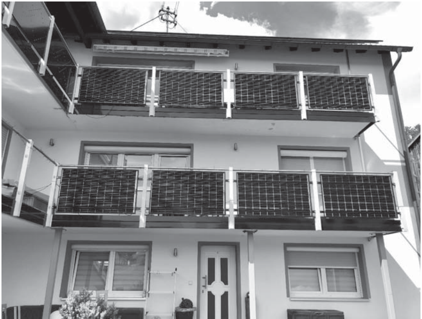
Abbildung 1.1: Mehrere Balkonkraftwerke (Copyright: Solarwatt)
